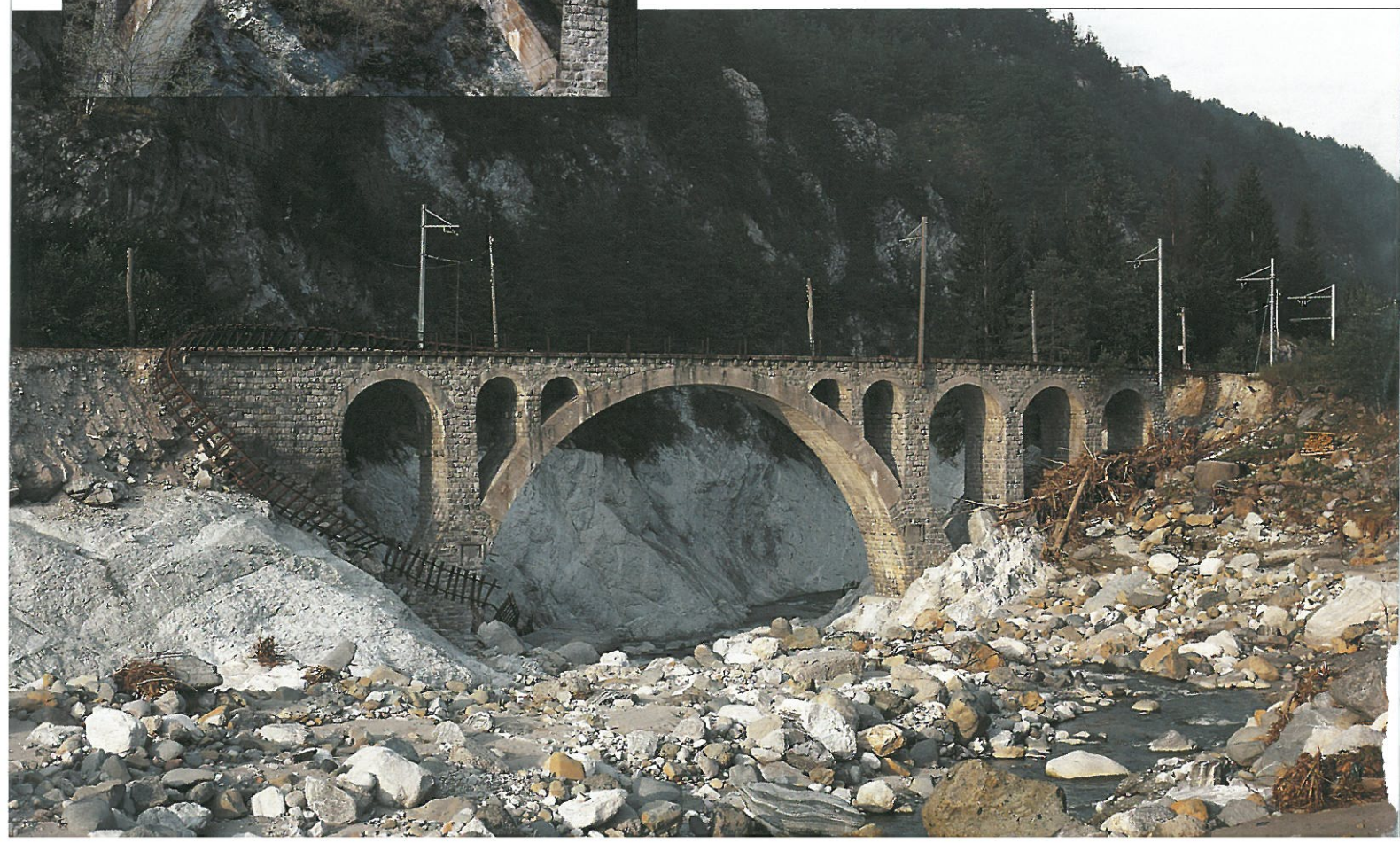
Foto 11.12: devastanti alluvioni colpiscono sempre più spesso le ferrovie italiane, sovente causate per colpa dell'uomo. Nel 1978 una di queste colpi la ferrovia della Val Vigizzo, compreso il ponte sul Melezzo nei pressi di Iselle-Olgia, strappando i binari e la linea aerea. Lo stesso ponte com'era, nella foto a lato, con la motrice 5 ed un carro di servizio nel 1977.
